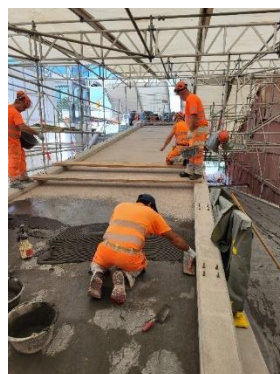
Einbau der Abdichtung und der Schlämme mit Einstreuung auf der Rampe mit einem Gefälle von 13%
