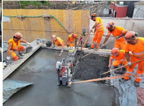
Einbau der Abdichtung aus UHFB SMARTUP [Structure] Typ UA auf der Passerelle und den Treppen.
