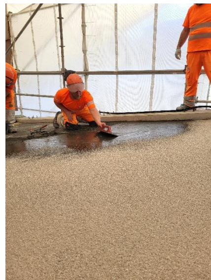
Mise en place de l'étanchéité et des boues avec saupoudrage de sable de quartz sur la rampe avec une pente de 13%.
