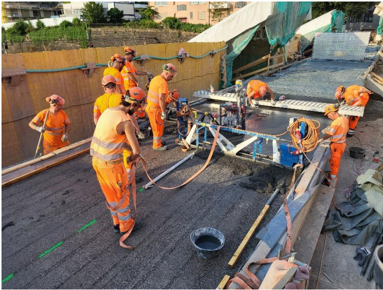
Pose de l'étanchéité CFUP SMART UP [Structure] sur la passerelle et les escaliers
