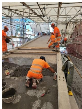
Mise en place de l'étanchéité et des boues avec saupoudrage de sable de quartz sur la rampe avec une pente de 13%.
