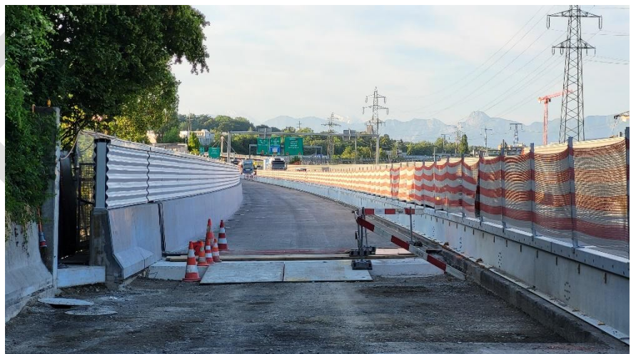
Mur de guidage terminé de la phase de construction 1
