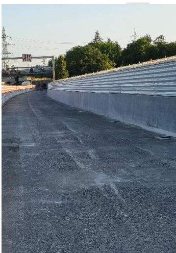
Mur de guidage terminé de la phase de construction 1
