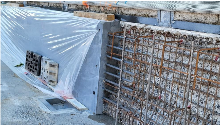
Mur de guidage terminé de la phase de construction 1
